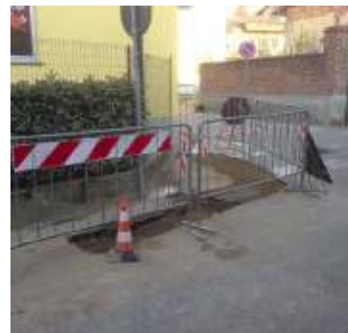
Lavori in corso a Briona per la posa della fibra ottica
