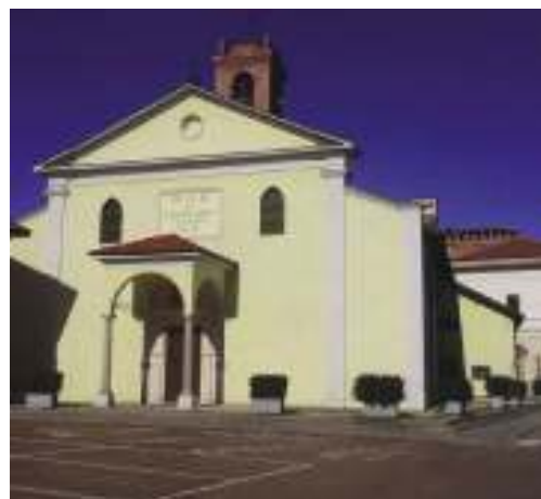
Le aree interessate dai lavori di rifacimento marciapiedi
